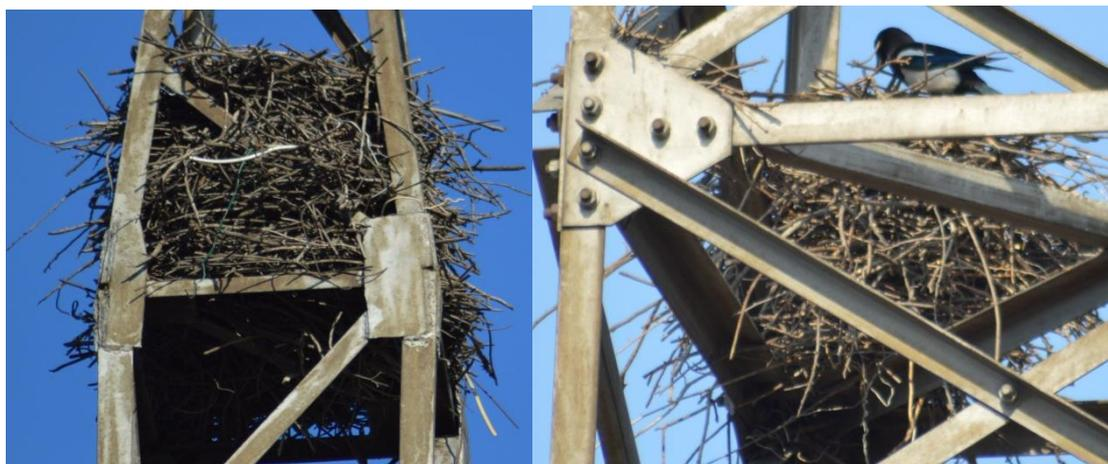
Рисунок – Гнезда сорок на металлических опорах ЛЭП
